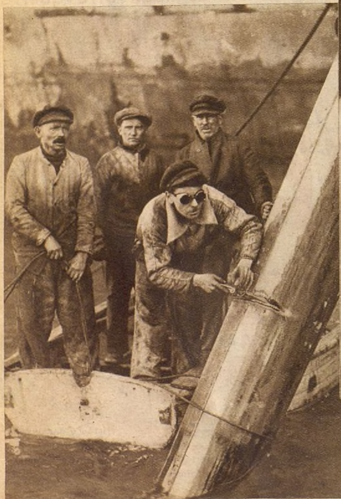
Después del siniestro del "Atlantique", se trata de aprovechar en lo posible los restos del buque. He aquí a unos obreros cortando a soplete el mástil caído del enorme transatlántico (Fotos Ortiz-Keystone)
