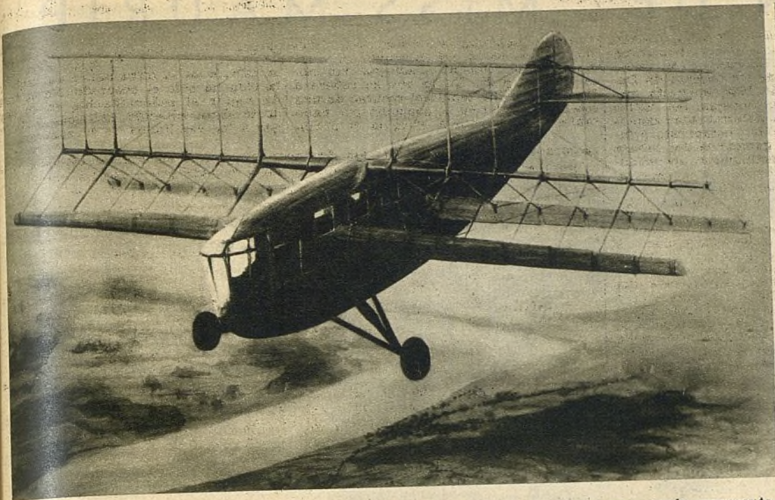
En la actualidad se está ensayando en Alemania el nuevo modelo de aeroplano cuyo vuelo representa la foto. Se trata de un aparato que no lleva hélice y está accionado por un sistema rotativo de alas que le permite también ascender y descender verticalmente
