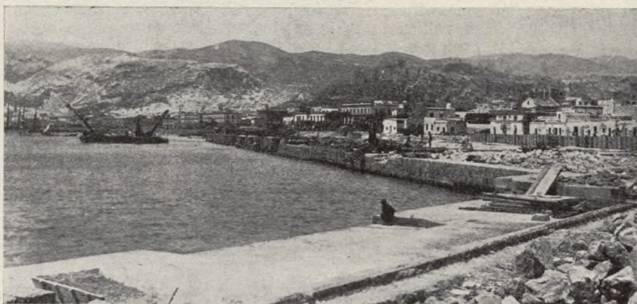
OBRAS DE LA CORTINA DEL MUELLE Y DIQUE DE LEVANTE
