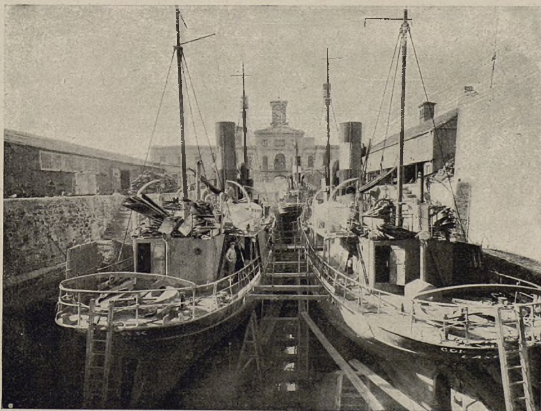
Vista del dique seco "Mauá" mostrando tres balleneros en seco, de los que se reparan en dichos talleres todos los años una cantidad, además de muchos otros buques. El edificio que se ve al fondo es la fábrica del gas de la Compañía.
