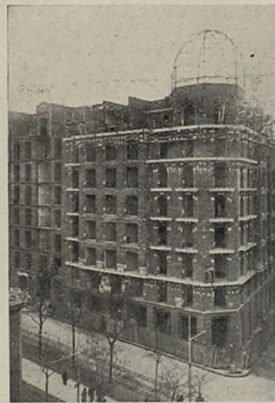
Vista de una de las obras en construcción
