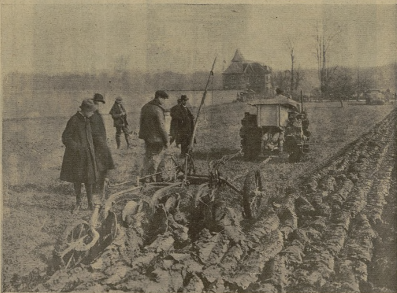
El Motocultor S. O. M. U. A., tipo A, para el gran cultivo, desprovisto de su FRESA ROTATIVA, y trabajando como tractor independiente, tirando de un arado trisurco de 12 pulgadas.
