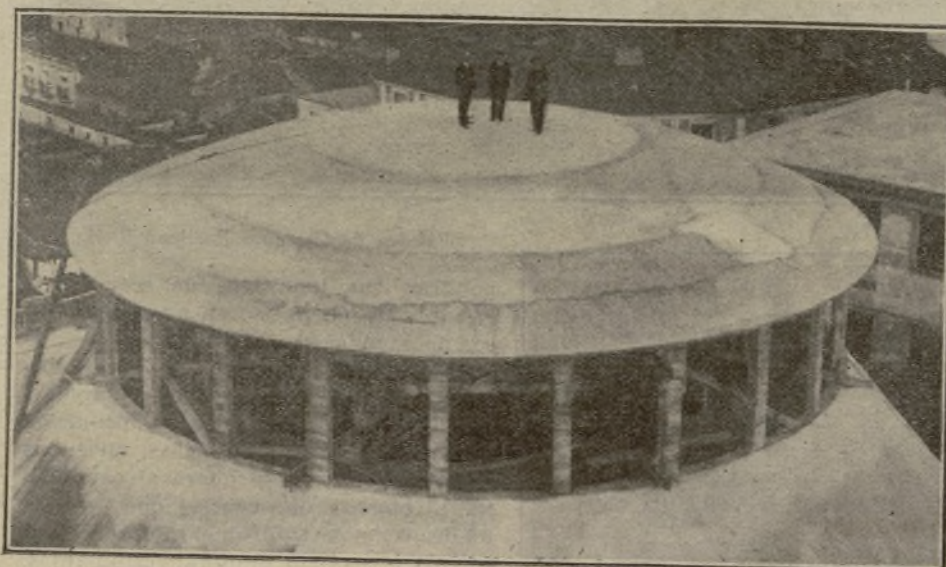
Construcciones de cemento armado. Cúpula de treinta metros.
