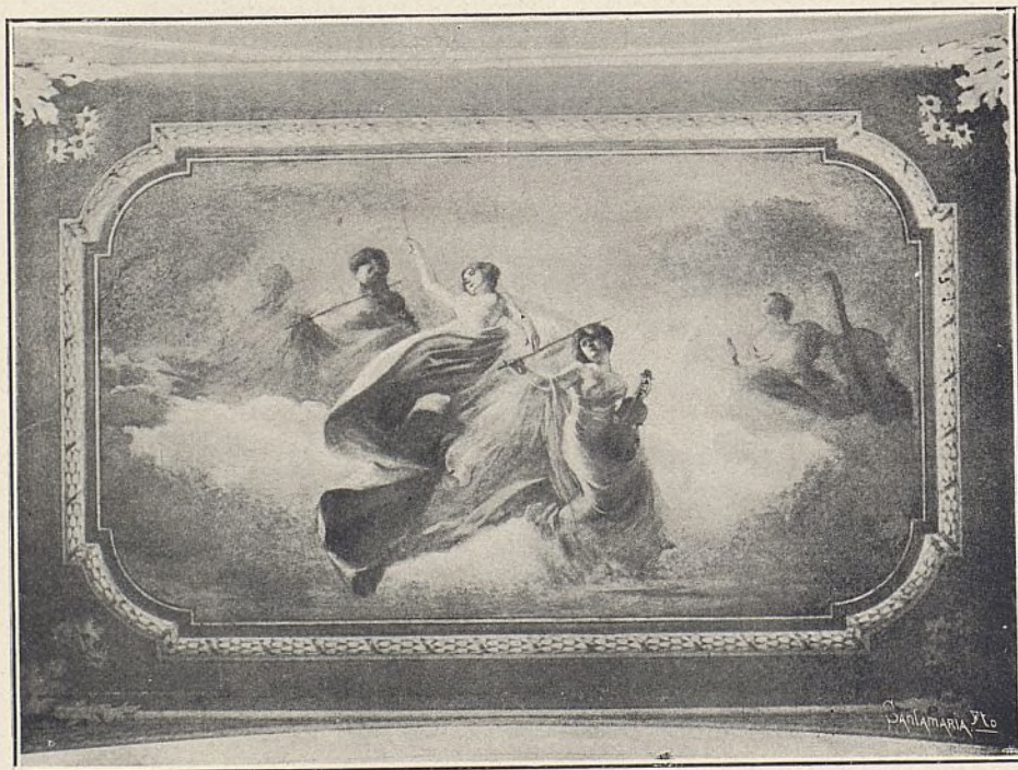
Detalle del techo.
