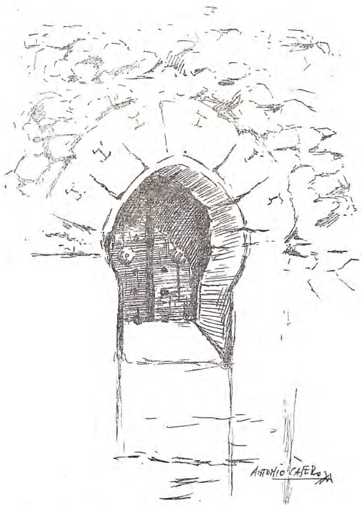
Figura 6. —Aparejo y arco de herradura de la torre de los Lujanes, en la calle del Codo.
