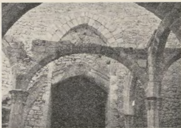
Fig. 22.—Capilla del castillo, ábside de la antigua iglesia y arco ojival de descarga
