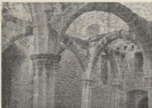
Fig. 21.—Capilla del castillo; nótese el engaste postizo de las arcadas
