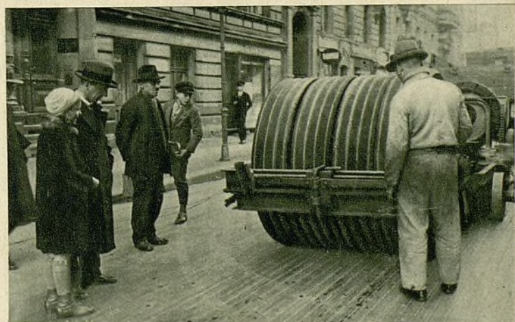
Para evitar que los coches patinen en el pavimento de las calles de Berlín, se ha pensado en que una máquina que marque estrías puede conducir a algo positivo.
