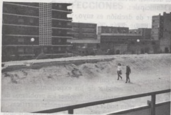
Antes de iniciarse las obras este era el panorama
