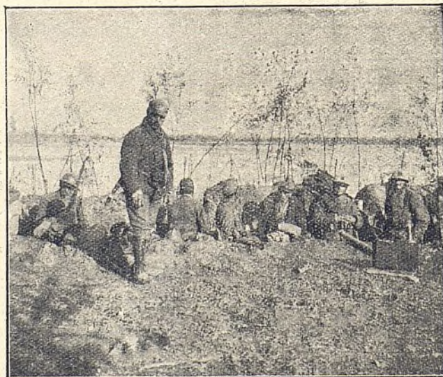
TRINCHERAS AVANZADAS EN EL PIAVE.
