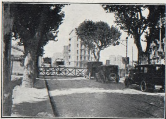
Paso a nivel, kilómetro 626'500 Madrid a Francia por la Junquera dotado de señales móviles y sonoras sistema Wig-wag
