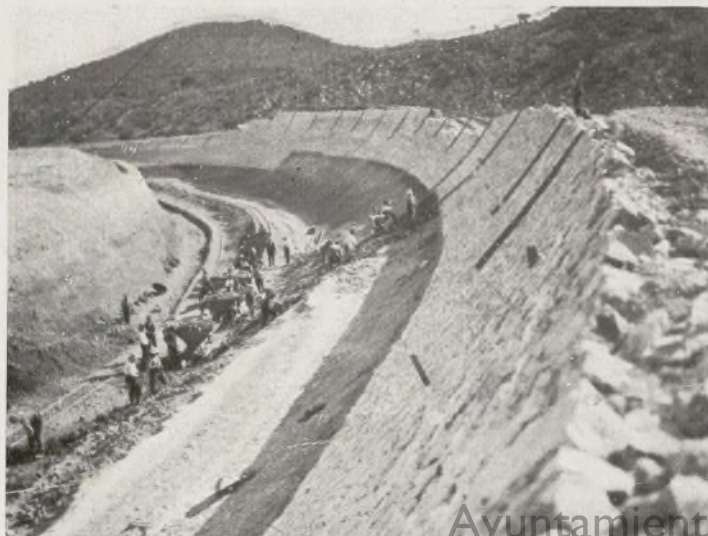
I. Viraje Oeste. — II. Trabajos de desmonte en el viraje Oeste. — III. Centro del viraje Oeste. — IV. Salida del viraje Oeste. Principio del hormigonado del mismo.
