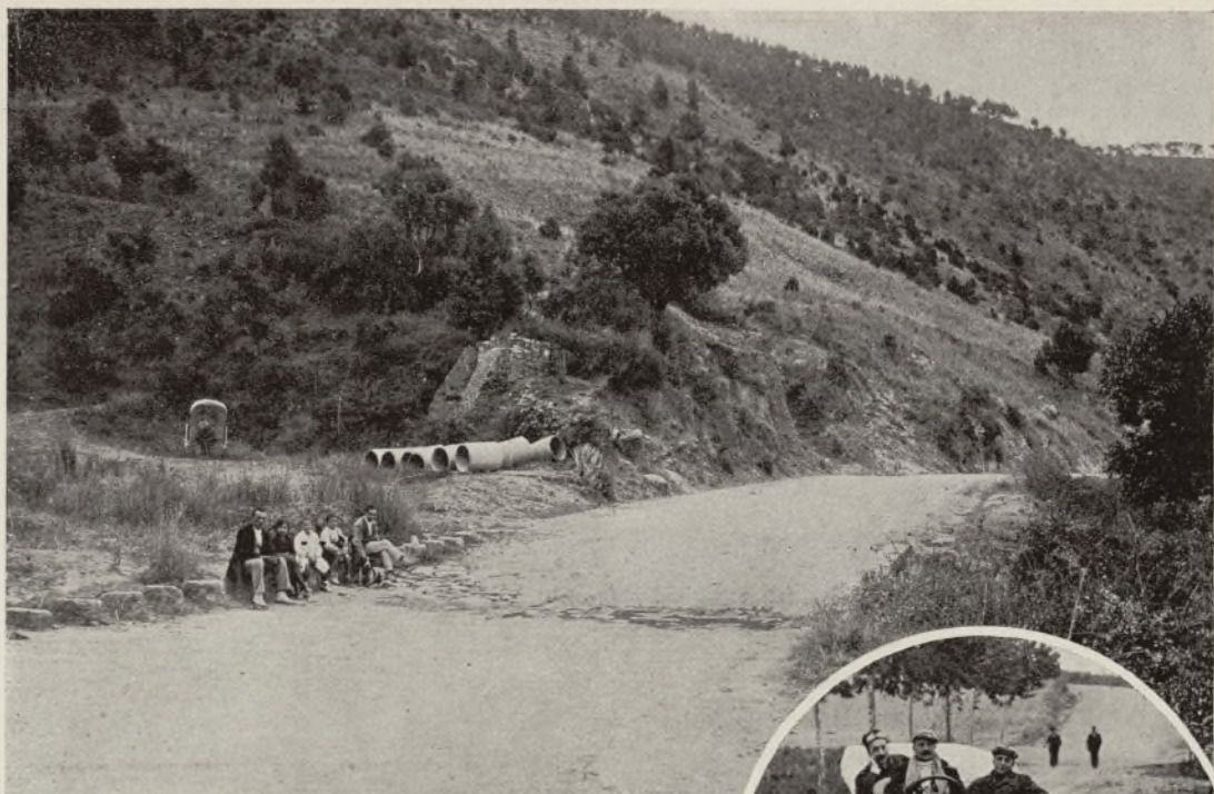
Los tubos preparados para suprimir el badén de La Passola (entre La Garriga y el Figaró).
