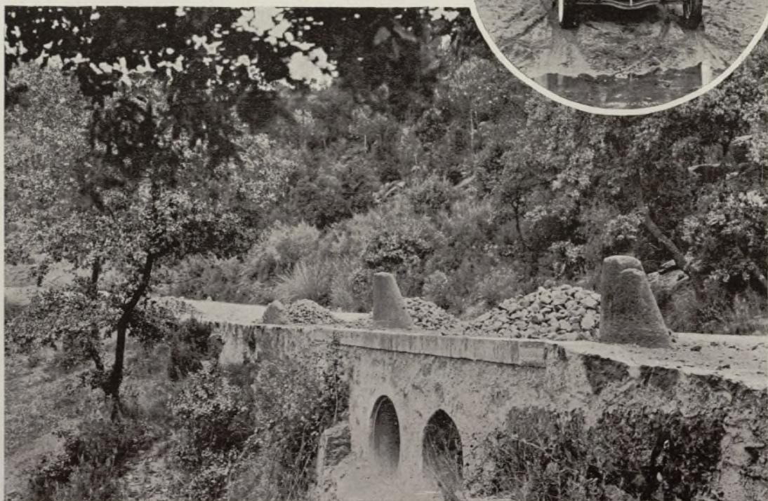
Badén de Casa Mas, suprimido con tubos facilitados por el R. A. C. C.
