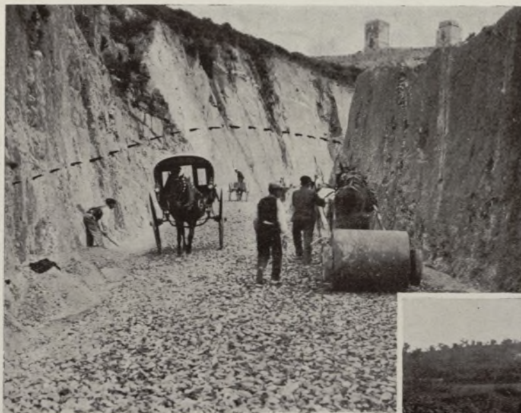
Cambio de rasante en construcción. La línea de puntos indica el antiguo trazado.
