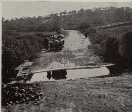
Cambio de rasante en construcción. La línea de puntos indica el antiguo trazado.
