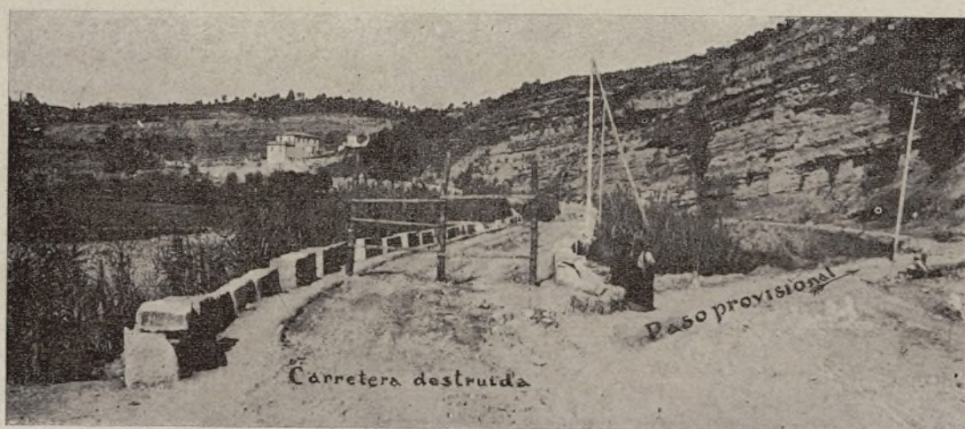
Paso provisional improvisado con ocasión de los efectos de las inundaciones.
