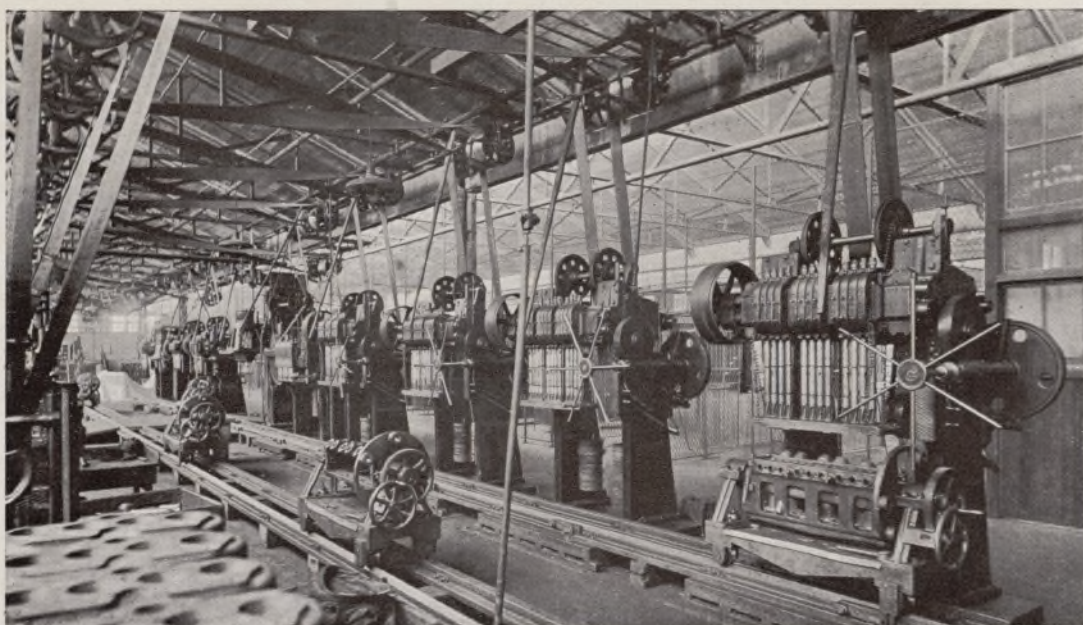
Vista de una sala de máquinas para la fabricación de bloques de cilindros.
