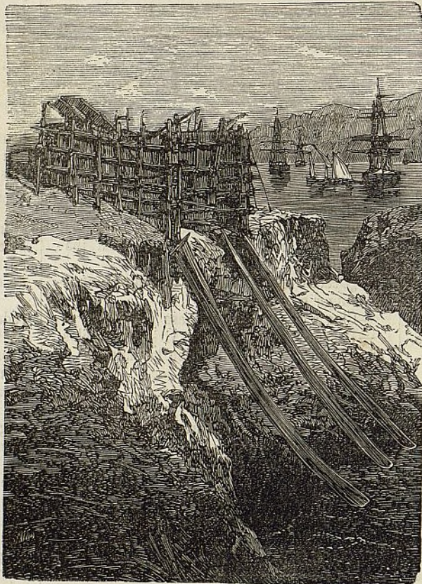
MANGUETAS Y DEPÓSITOS PARA EL TRASBORDE DEL GUANO EN LA ISLA DE CHINCHA.
