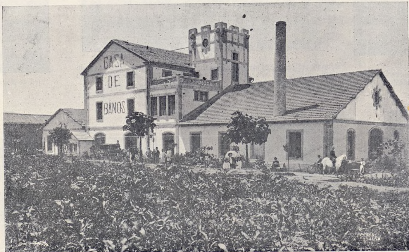
Casa de Baños.—Vista tomada del paseo de la Herradura
