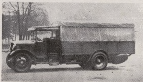
Camión Panhard, tipo 4.500 kgs., con motor alimentador por gasógeno.
