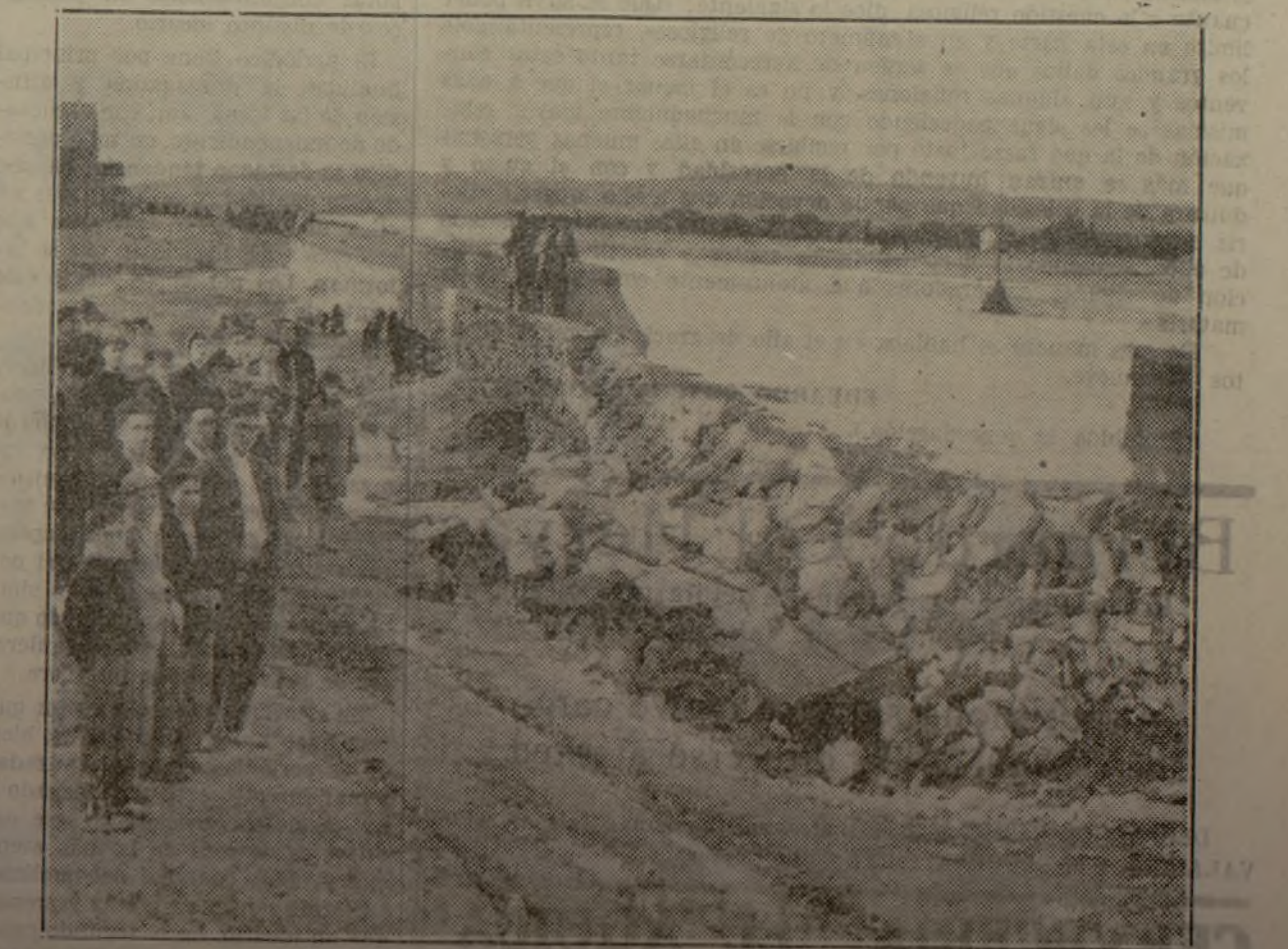
Tercer trozo del malecón que se hundió, frente a la calle de Costa, y cuyo estado demuestra la consistencia de las obras
