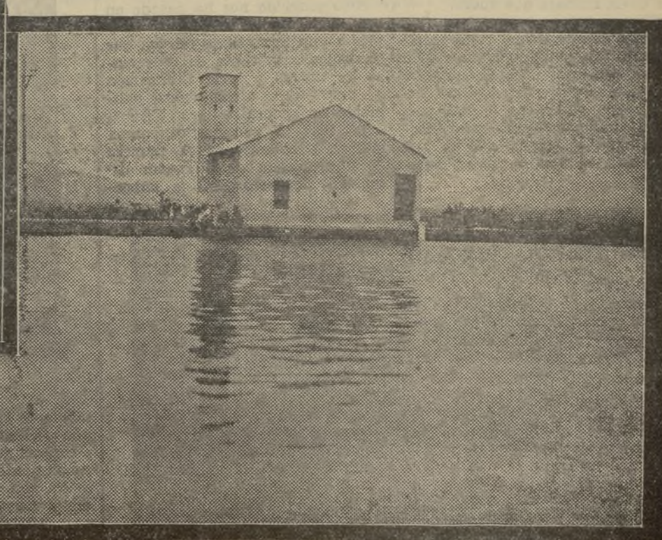
VISTA PARCIAL DEL ESTANQUE REGULADOR, DE 50 METROS DE DIAMETRO, SITUADO A 57 METROS DE ALTURA DEL NIVEL DEL POZO
