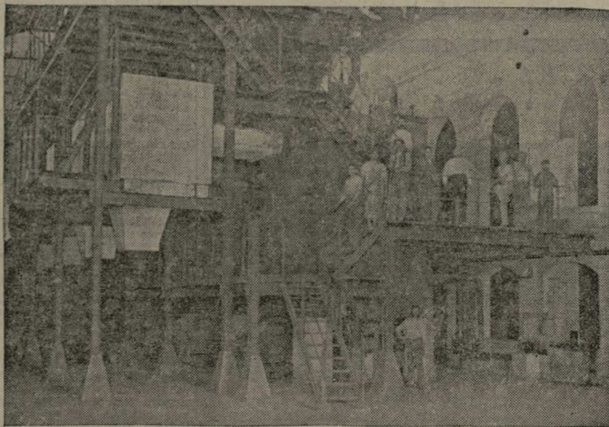
HORNO MECANICO PARA LA C REMACION DE LA PIRITA DE HIERRO
