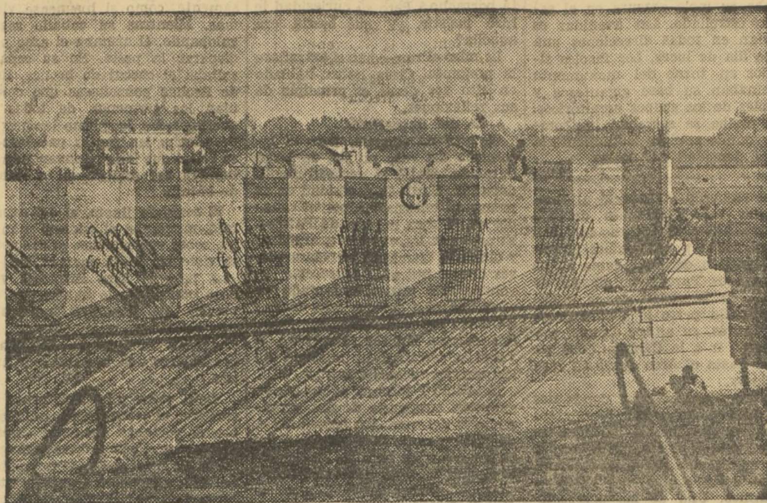
UN DETALLE QUE DA A CONOCER LA FORMA EN QUE TRABAJA LA COMPANIA DEL GAS LEBON. NOTESE EL AGUJERO POR DONDE DEBIA PASAR UNA VEZ TERMINADO EL PUNTE, LA TUBERIA DE GAS
