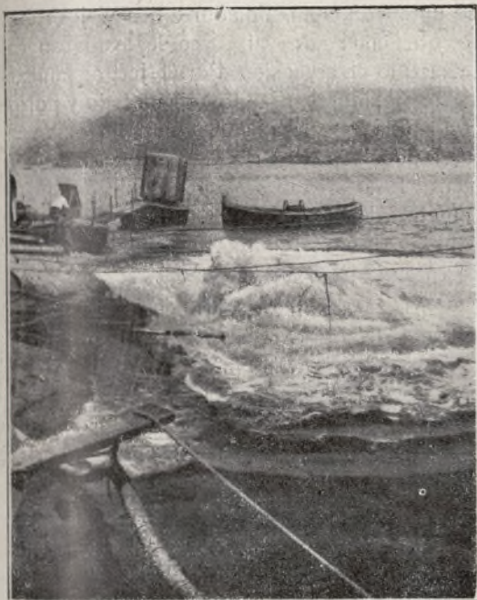
Un submarino en actividad para poner a flote los restos del acorazado Libertad en Tolón. Una poderosa corriente de aire es inyectada para variar los compartimientos.
