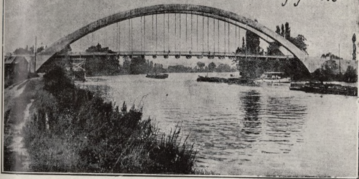
El nuevo puente sobre el Sena, en Saint-Pierre-du-Vauvray (Eure), cuyo arco de 131 metros, de cemento armado, es el mayor del mundo.
