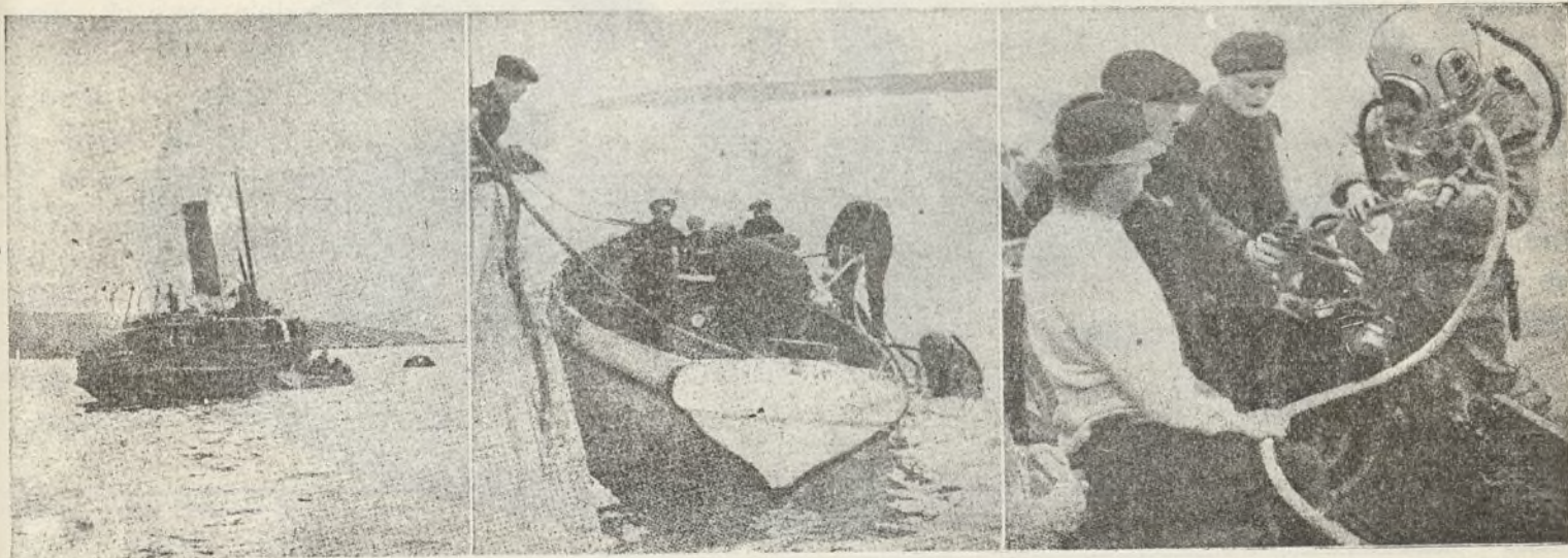
Las presentes fotografías nos muestran al remolcador que transporta los buzos, anclado sobre los restos del contratorpedero alemán "AE 70", y el descenso de los buzos que utilizan el acetileno por vez primera como medio de iluminación submarina.
