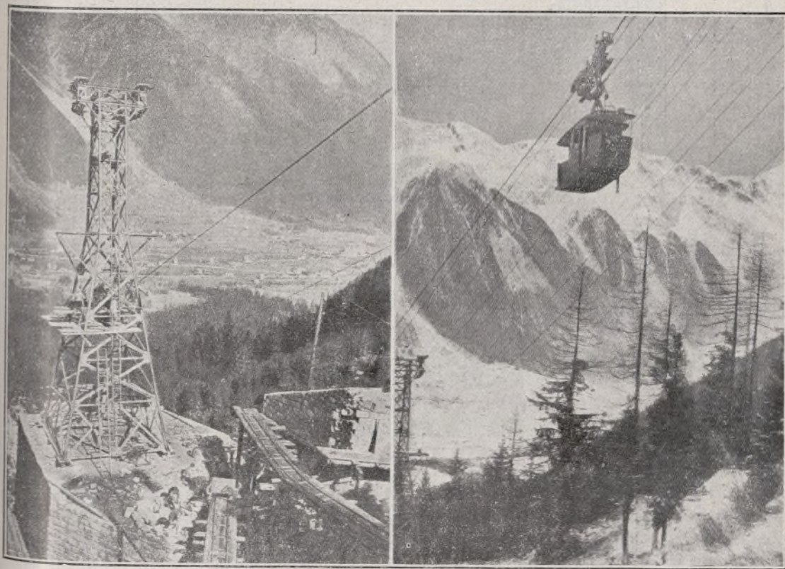
He aquí un poste en terminación del funicular aéreo.—A la derecha un muro para-avalanchas; al fondo, carretera y valle de Chamonix En coche aéreo circulando por uno de los puentes más fuertes.—El coche, con 18 viajeros sube o desciende a la velocidad de 2 m. por segundo
