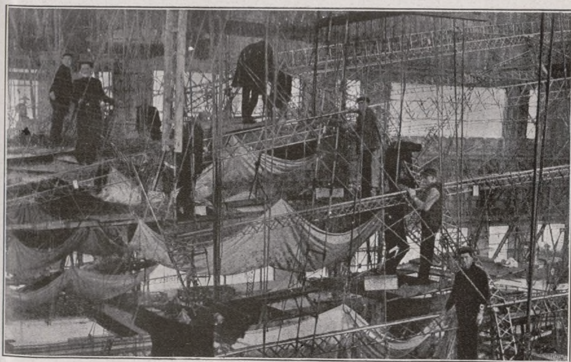
ARMADURA DEL CASCO DE UN DIRIGIBLE.—La armadura de metal, una vez terminada, es recubierta de tisú finísimo impregnado de caucho, que la dividen en cámaras aisladas entre sí. La pérdida de helio a través de estos tisús, es muy poca, viene a representar la mitad que la del hidrógeno, habitualmente empleado.
