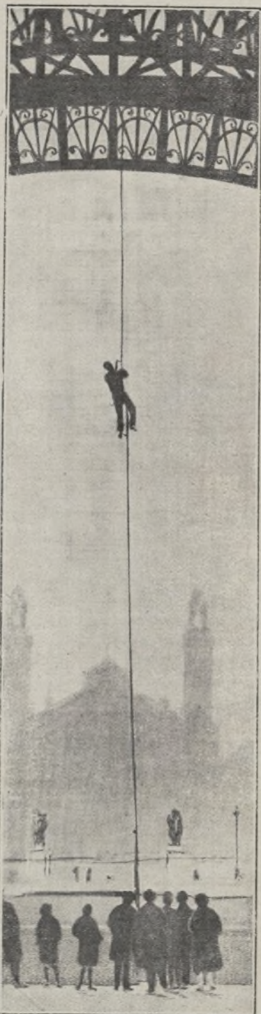
Las pruebas verificadas con el «Oustiti» trepador no pudieron ser más satisfactorias. Con un cable tendido desde el primer piso de la torre Eiffel el autor subió y bajó con gran precisión, dando a todos los presentes la sensación de una gran seguridad.
