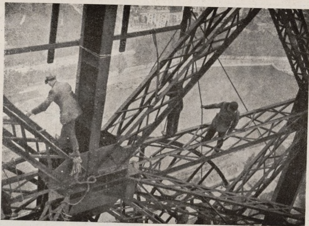
Obreros trabajando por el armazón de la torre Eiffel, haciendo la instalación eléctrica.
