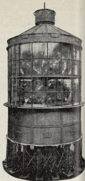
El faro de Dijón, uno de los más poderosos del mundo, sus rayos luminosos alcanzan a 32 kilómetros, se compone de ocho lámparas con un millar de bujías.
