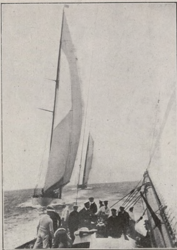
Los yachts de regatas, por su enorme velamen, tienen que poseer para asegurar su estabilidad largas quillas de plomo.
