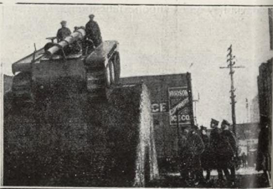
Entre las armas más modernas figuran los cañones montados sobre orugas, que ensaya en la actualidad el ejército Norteamericano. Montadas sobre este artefacto las baterías pueden circular sobre toda clase de terrenos y subir las más empinadas pendientes.
