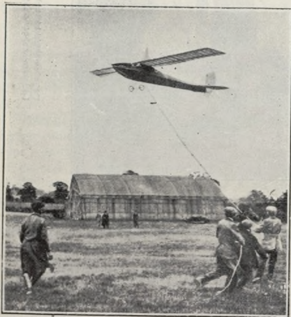
El nuevo avión sin motor en el momento de iniciar su vuelo, al ser lanzado al aire, mediante unas cuerdas Sandows.
