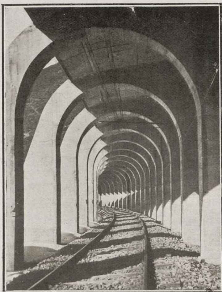
Línea de León a Gijón.—Entrada al túnel de defensa contra las nieves.
