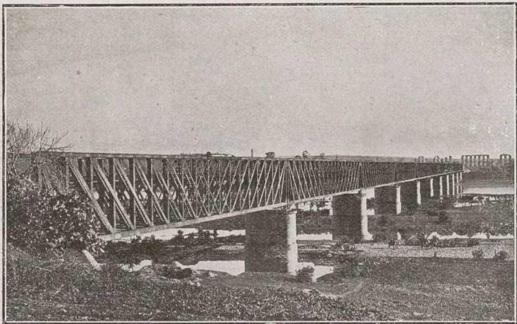
Línea de Mérida a Sevilla.—Puentes sobre el río Guadiana. (11 tramos metálicos).
