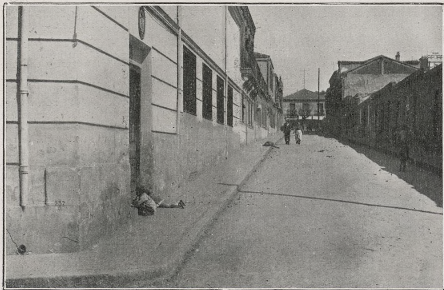
Calle de la Cruz, del Puente de Vallecas, pavimentada con hormigón blindado por la S. A. CONSTRUCCIONES Y PAVIMENTOS
