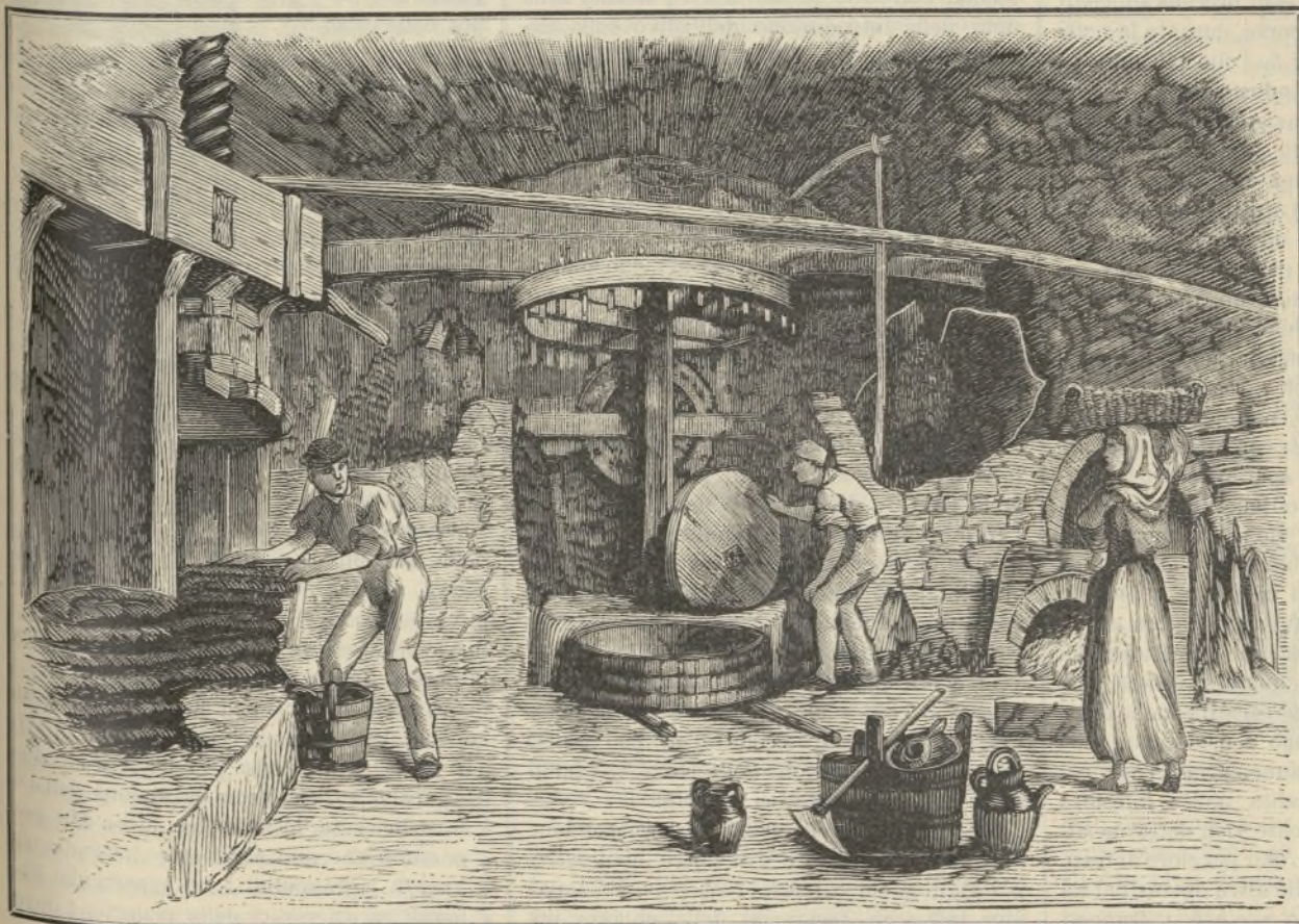
Fig. 28. - OPERAZIONE DELLA SPREMITURA COL VECCHIO TORCHIO.
