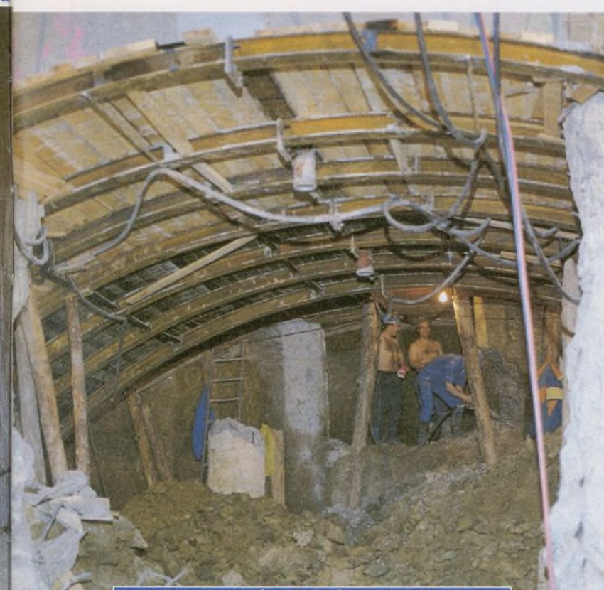
Realización del túnel en mina
