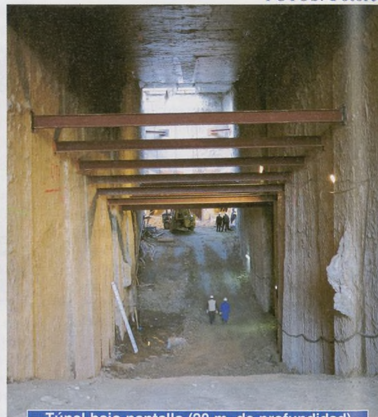
Túnel bajo pantalla (20 m. de profundidad)
