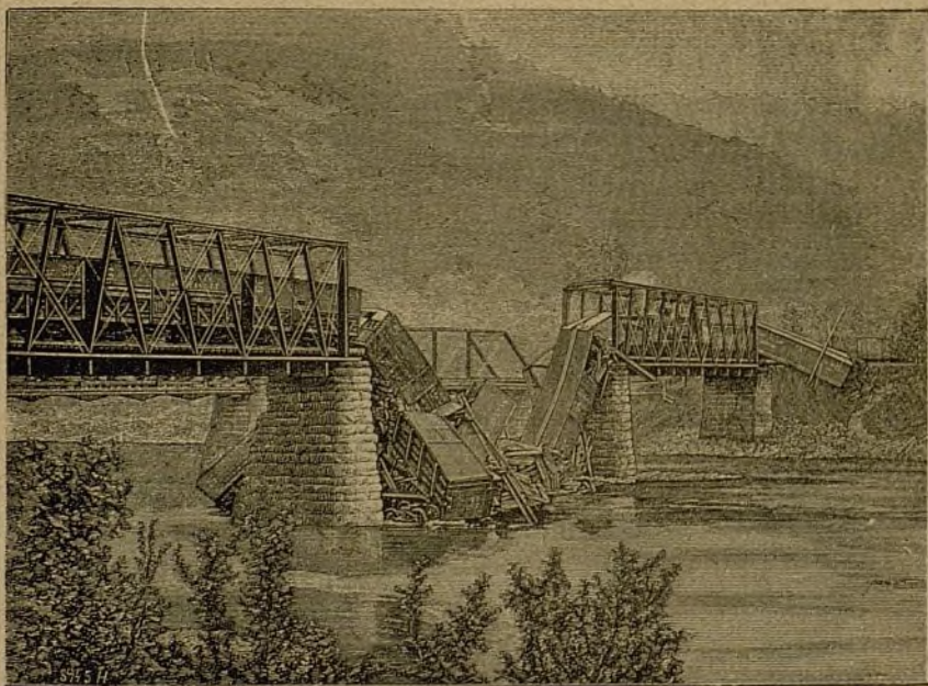
Fig. 11.— Caída de un puente en Hantock, N. J., ferrocarril de New-York, Lake Erie and Western Railroad (7 de Junio de 1888).
