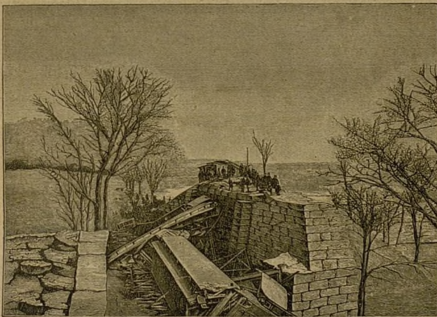
Fig. 8.—Caída del puente de Bussey, ferrocarril de Boston and Providence (14 Marzo de 1887).
