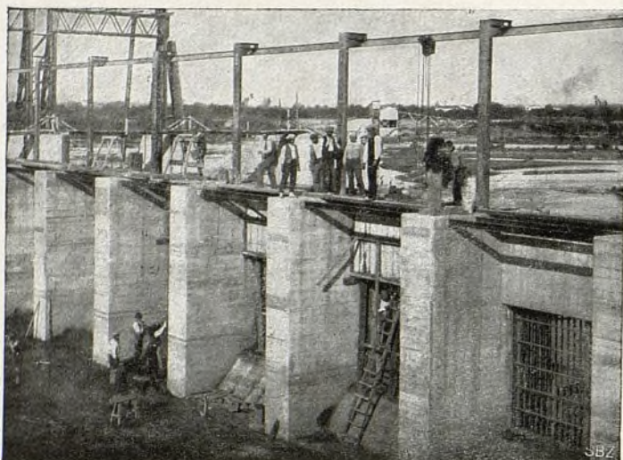
Fig. 61.—Embocadura con enrejados anchos; vista desde el interior.
