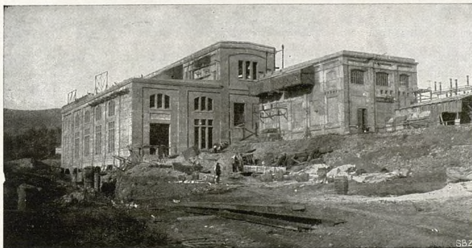
Fig. 47.—Casa de máquinas y casa de transformadores. Vistas tomadas del lado Sur. Delante, a la derecha, el taller de reparaciones que servía como casa de transformadores durante la construcción.
