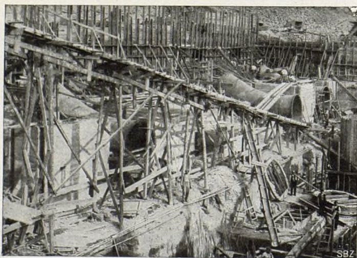
Fig. 77.—Tubos en curva a la entrada de la casa de máquinas. (8 Agosto 1913).
