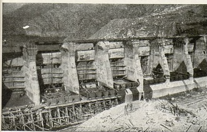
Fig. 18.—Compuertas en situación horizontal durante el montaje protegidas por compuertas de madera. En el plano de las compuertas fijas. Compuertas núms. 4 y 7 colocadas ya en su arista de giro.
