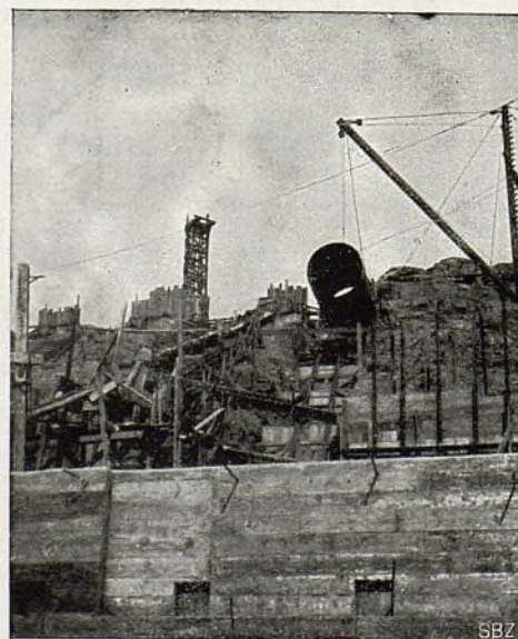
Fig. 79.—Montaje de la tubería de presión.
