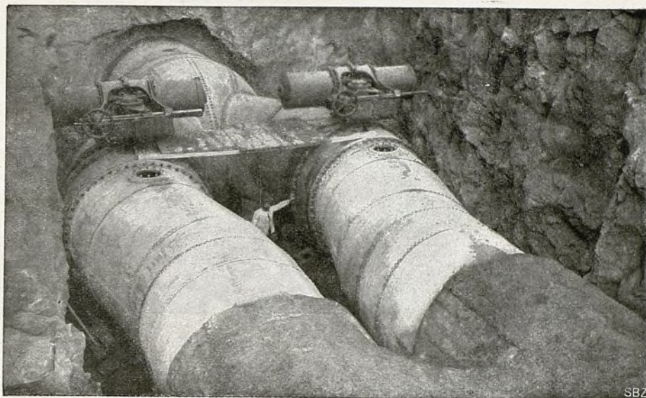
Fig. 34.—Bifurcación completamente montada de la tubería de presión, antes de su macizado.
