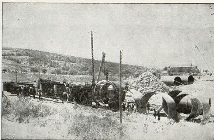
Fig. 37.—Elementos de la tubería de presión preparados para su colocación.
