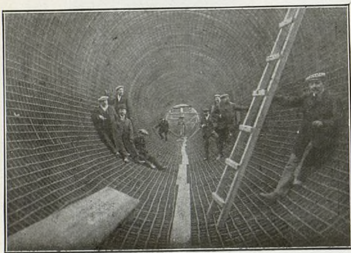
Canal de Aragón y Cataluña.—Armadura del Sifón de Albelda, construido con cemento «Asland».
