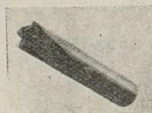
Fresa trépano empleada para obtener probetas cilíndricas en el espesor mismo de las piezas.
