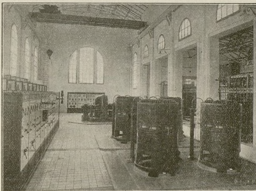
Fig. 16. — Sala de convertidores del Metropolitano Transversal.
