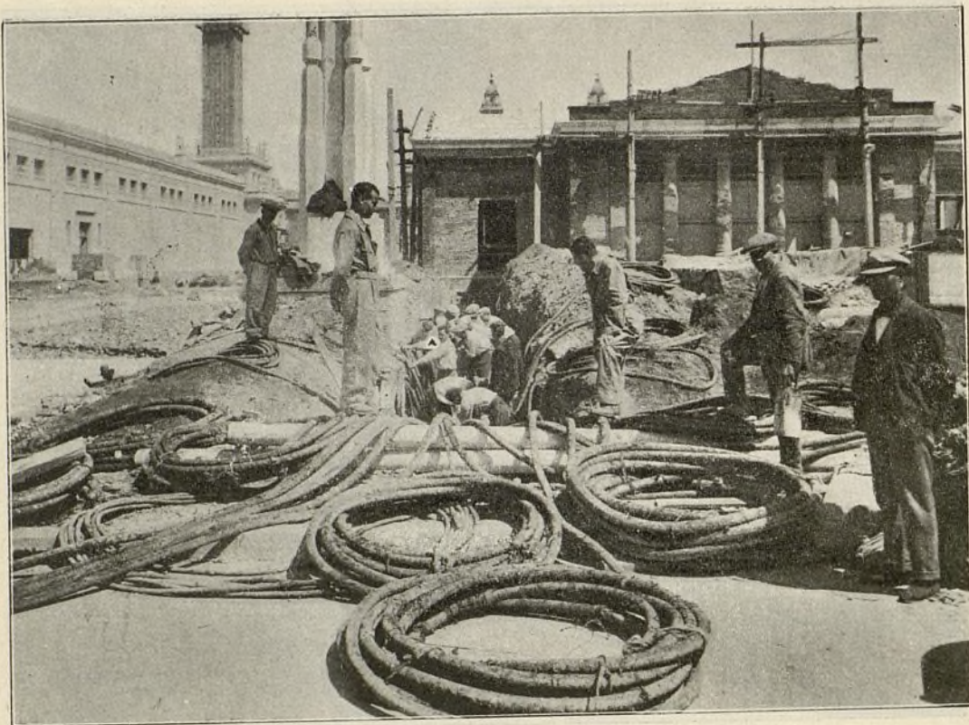
Fig. 18. Colocación de cables en la zanja de entrada al Pabellón de Electric Supplies Co, S. A.
