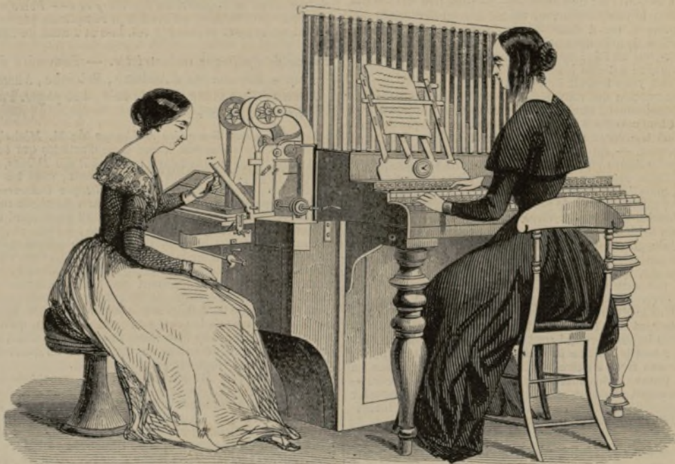
(Clavier typographique du capitaine Rosenborg. — Fig. 1re, Machine à composer.)
