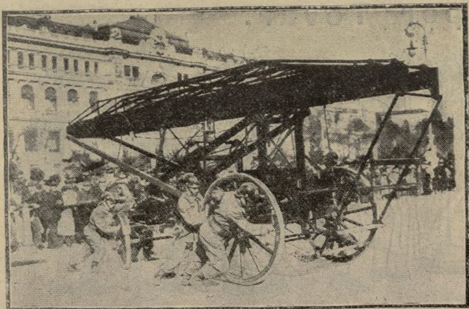
SIMULACRO DE BOMBEROS EFECTUADO EN MADRID EL LUNES 24.—UNA MANIOBRA CON EL CARRO-ESCALA MAGIRUS, DE 22,50 METROS DE DESARROLLO (Fotografías ALFONSO.)
